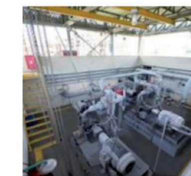
PARQUE DE BOMBAS DO ESTIRENODUTO: PETROBRAS, REMAN, MANAUS STYRENE DUCT PUMP AREA: PETROBRAS, REMAN, MANAUS
