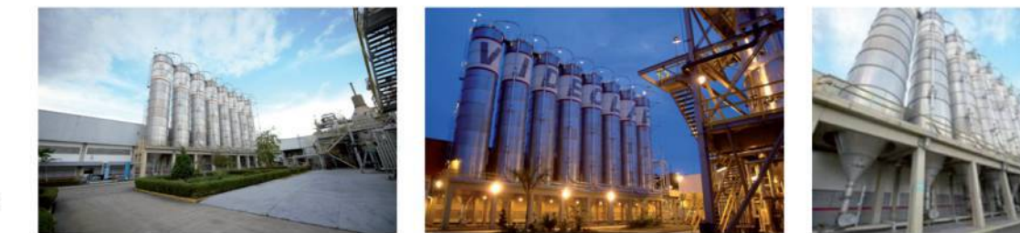
SILOS DE RESINAS RESIN SILOS
