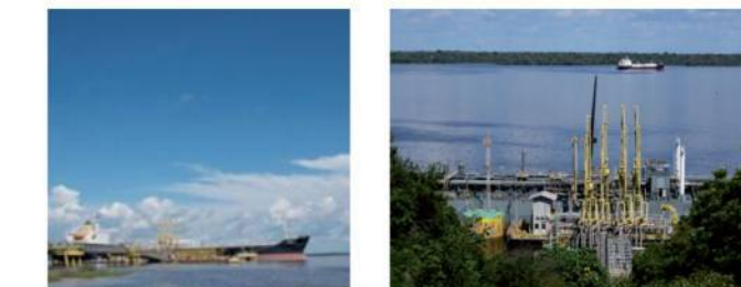
POSTO DE OPERAÇÕES FLUTUANTE: PETROBRAS, REMAN, MANAUS FLOATING OPERATIONS STATION: PETROBRAS, REMAN, MANAUS
