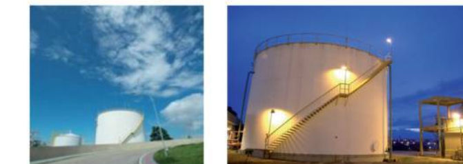
VIDEOLAR-INNOVA: TANQUES ONDE CHEGA O MONÔMERO DE ESTIRENO VIDEOLAR-INNOVA: STORAGE TANKS THAT RECEIVE THE STYRENE MONOMER
