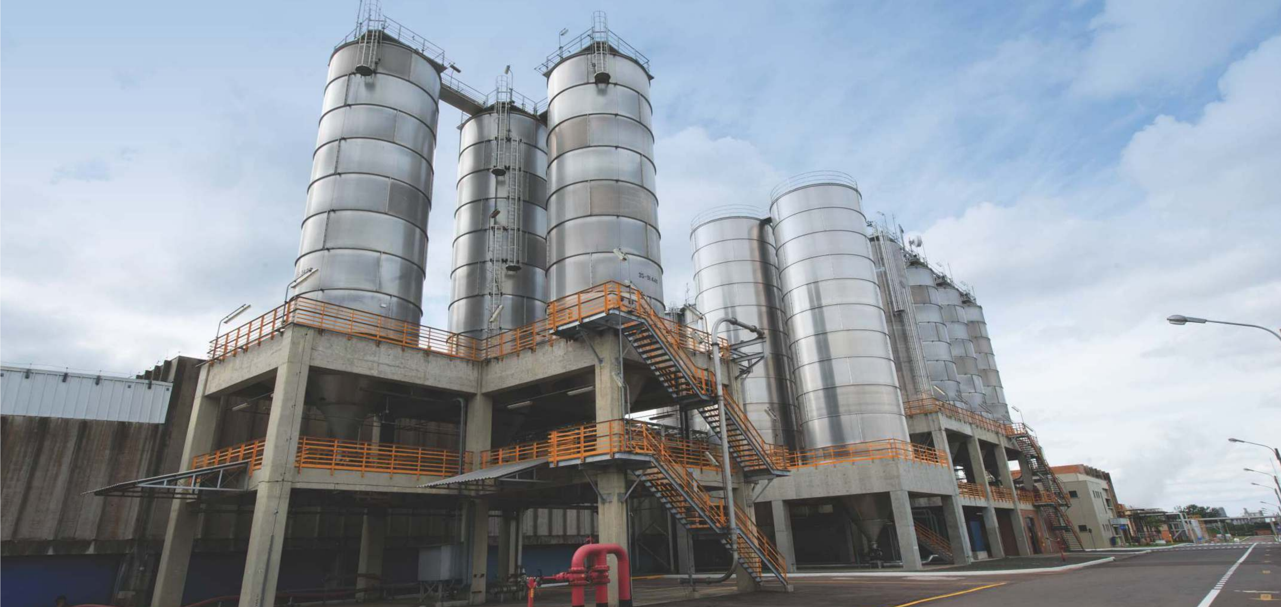
VIDEOLAR-INNOVA, UNIDADE II, TRIUNFO (RS): VISTA GERAL DOS SILOS GRANELEIROS.
