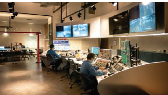
Sala de Controle: Unidade II (Triunfo, RS)
