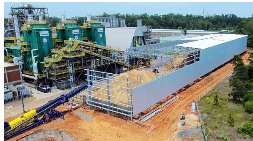
Unidade II, Triunfo (RS), petroquímica: implantação da cobertura do pátio da biomassa.
