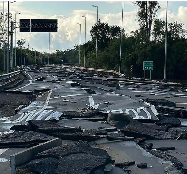
BR 386, Tabai-Canoas highway, Polo Petroquímico do Sul (Rio Grande do Sul)
